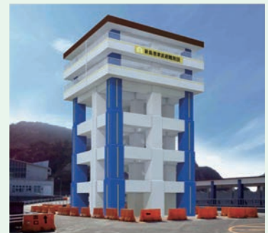
新島港津波避難施設（津波避難タワー）
