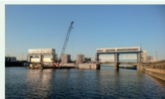
水門耐震対策工事（今井水門）
