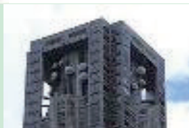
防災行政無線アンテナ
