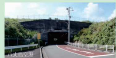
空港土木施設
