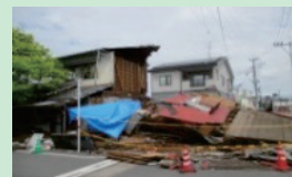
熊本地震での木造住宅の被害
